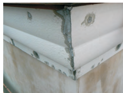
stuccatura e fissaggio del cornicione
