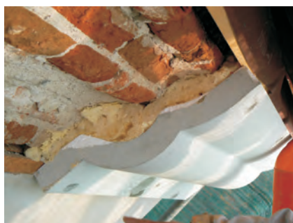
posa del profilo DEKOVER con colla poliuretanic
